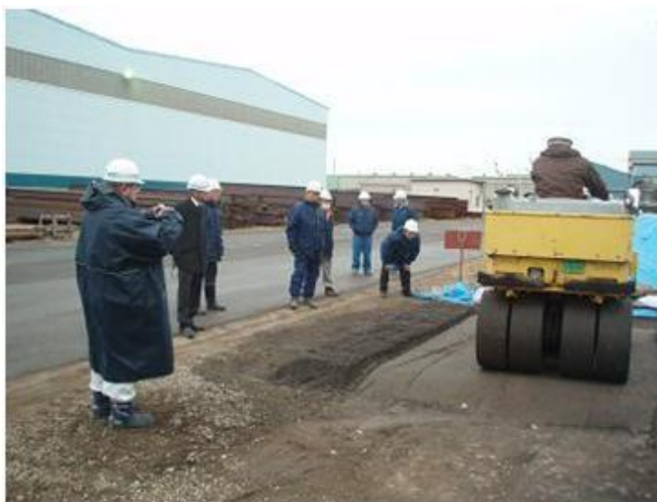
< 図－1 締固め試験状況 >
